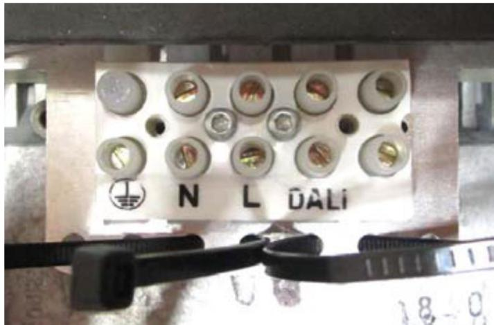
Le luminaire disposant d'une Classe électrique 2, il est impératif d'utiliser des conducteurs disposant d'une double isolation.
